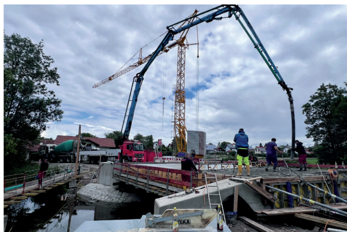
Baufortschritt an der Brücke in Frauendorf
